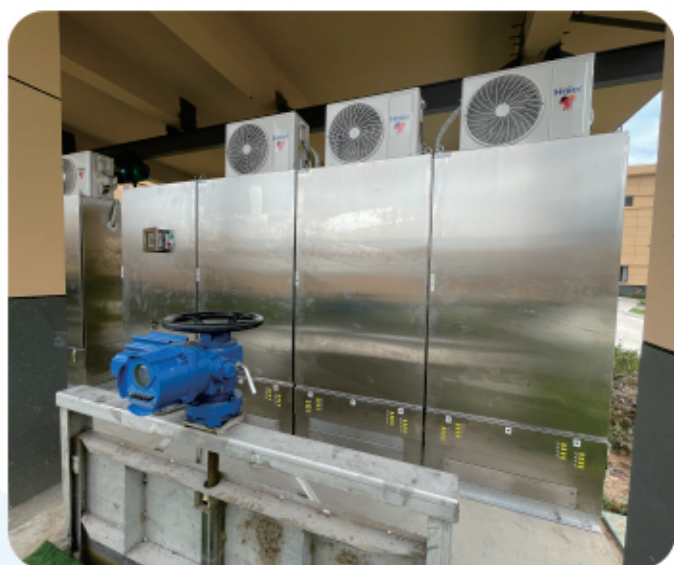
福州大学城污水厂提标扩容项目（12万吨/日）
